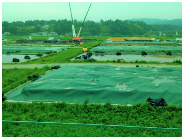
シートで覆われているフレコンバックの山
