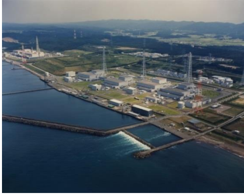
柏崎刈羽原子力発電所全景
